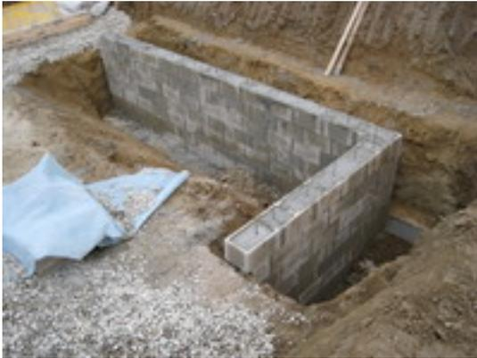
Diese Woche wurde der Aushub beendet und eine Stützmauer zum Unterfangen der Fundamentplatte gebaut.
