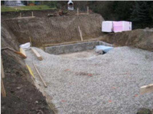
Weil die Garage unmittelbar an das Haus anschließen, aber um ca. 1,5 m tiefer als der Keller sein wird, muß eine zusätzliche Stützmauer gebaut werden um das Fundament des Hauses zu unterfangen <http://pharmacieviagra.com/boutique/acheter-viagra/> . Der Rollschotter wurde zum größten Teil geliefert und auf der übrigen Fläche des zukünftigen Fundaments verteilt. Bilder davon sind [hier](#) .
